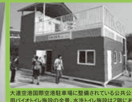
大連国際空港駐車場に整備されている公共公衆用バイオトイレ施設の全景。水洗トイレ施設は2階にあり、1階が浄化槽施設となっている。
