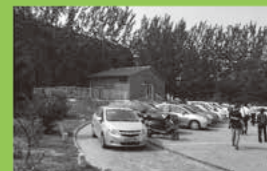
大連市郊外鉄道駅駐車場に整備された公共公衆用バイオトイレ施設の全景。建物水洗トイレ施設であり、建物の左側の柵で囲まれた部分に浄化槽施設がある。
