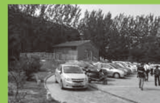
大連市郊外鉄道駅駐車場に整備された公共公衆用バイオトイレ施設の全景。建物水洗トイレ施設であり、建物の左側の柵で囲まれた部分に浄化槽施設がある。
