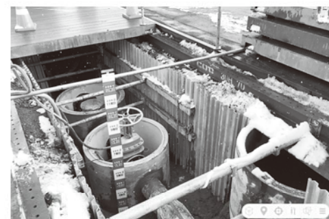
マンホール設置状況
