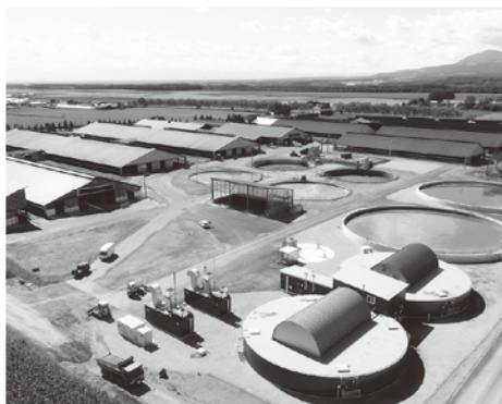
バイオガスプラント
