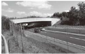
スイスのハイウェイN1(Oulens-sous-Echallens)視察したスイスの野生生物の生息域の分断を緩和するオーバーパスで、橋長42.15m、幅員42.7mのコンクリート橋、総工費約6億2千万円。
