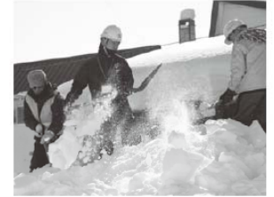
民家を除雪している様子
