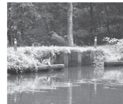
写真2:運河に設置された脱出用ランプ
