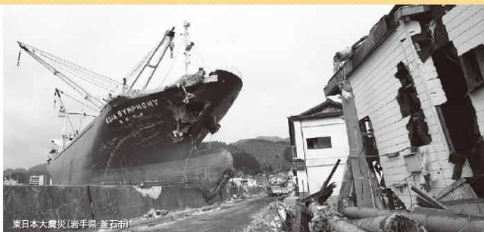
東日本大震災(岩手県・釜石市)
