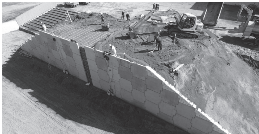
オホーツク地域創生研究パークに実物大補強土壁を設置し、積雪寒冷環境での劣化メカニズムを解明(寒地土研との共同研究においてSAFER所属教員が撮影)
