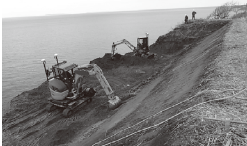
ICT施工の様子
