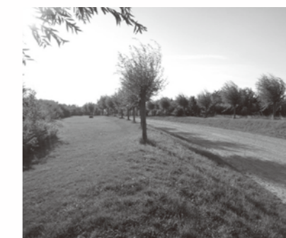
写真2: 人と動物が利用できるオーバーパス。中央を人や車両が通行し、両側の緑地帯を野生動物が利用する
