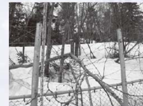
【写真3】倒木による柵破損箇所
