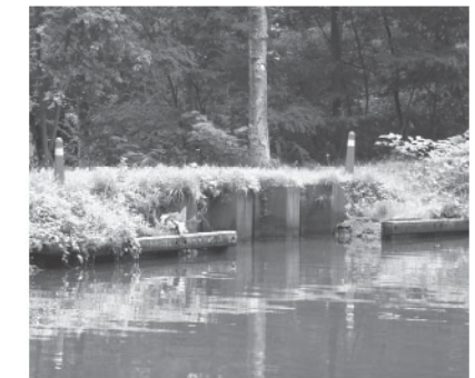
写真2:運河に設置された脱出用ランプ
