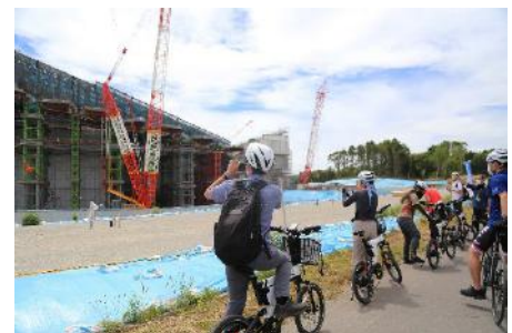
写真1. 建設中のボールパークを見学
