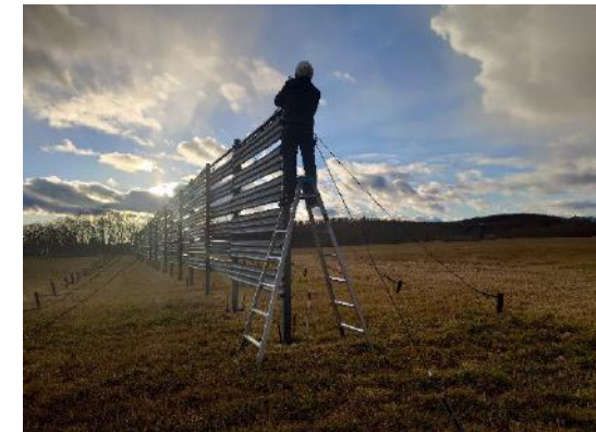
写真1. 簡易型タイムラプスカメラの現地設置作業状況(令和3年11月26日)
