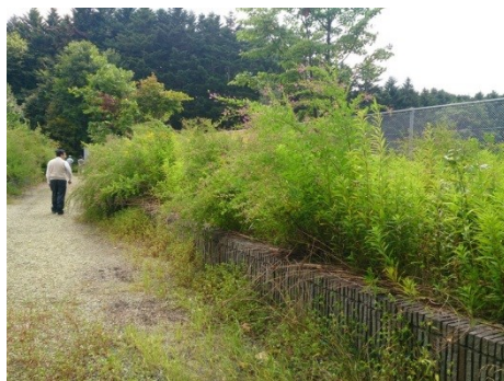
オーバブリッジの現地確認
