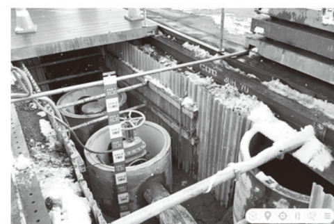
マンホール設置状況
