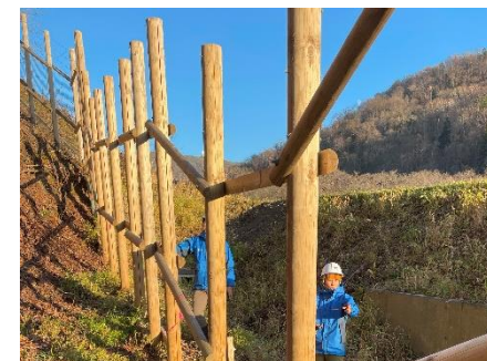
写真3.音威子府バイパス木製立入防止柵
