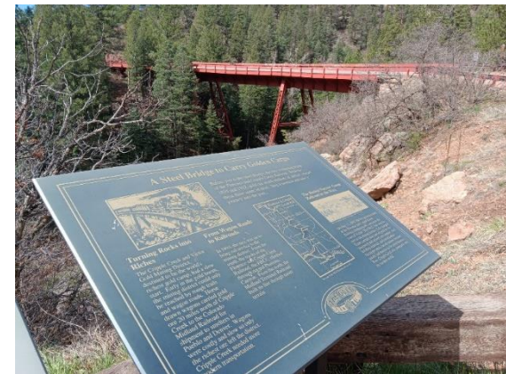
写真2.「Gold Belt Tour Scenic Byway」 鉱山用の鉄道跡が道路になっており、当時の鉄道橋を、道路橋として利用しており、この歴史的な経緯を説明したボード
