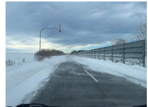
図2. 吹き払い柵の現地踏査
