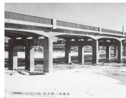
札幌一条大橋(昭和14年12月竣工)
