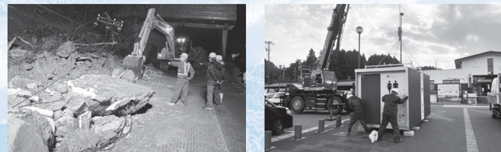
道路啓開作業の様子（石川県輪島市）
