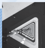
橋の床内部。 約1km先まで 続く空間。 写真だと 模様しか 見えない…。 残念!
