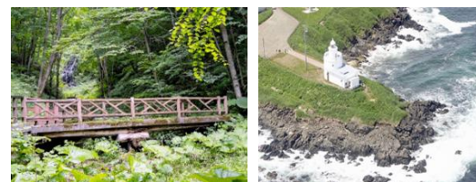
写真1.土木学会選奨土木遺産2件 (木コングリート橋・木直川橋(左)、納沙布岬灯台(右))
