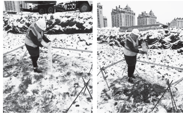
建設現場で凍結防止剤を散布している様子
