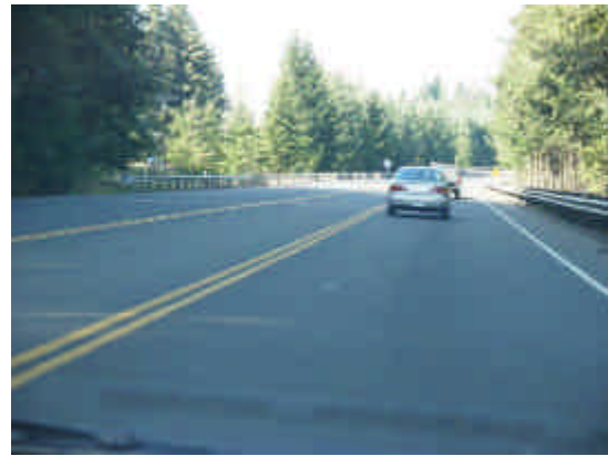
図表 33 一般道路部（真ん中の車線は右左折レーンが連続して続いている）
