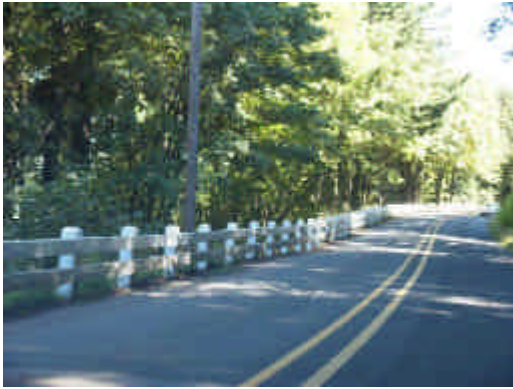
図表 17 左側のガードレールは木材を鋼板で強化したもの
